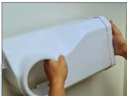
11 - O acabamento plástico deve ser fixado na carenagem Ø100
