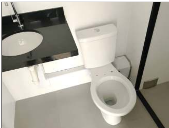
13 - Kit módulo de sobrepor instalado
