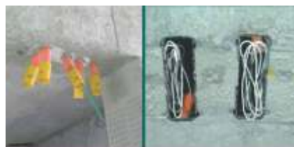
Todas emendas entre eletrodutos com luvas específicas
