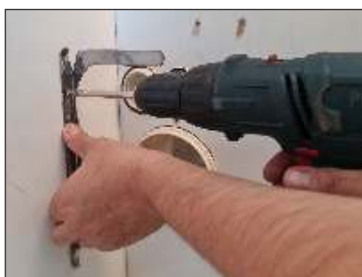
5 - Parafusar os suportes de inox na parede
