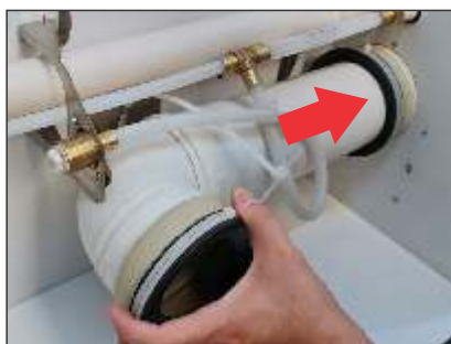
8 - Instalação do PVC Ø100
