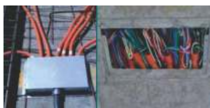
Utilização de caixas de “espera lacrada” com os fios que irão descer nas paredes / QDL
