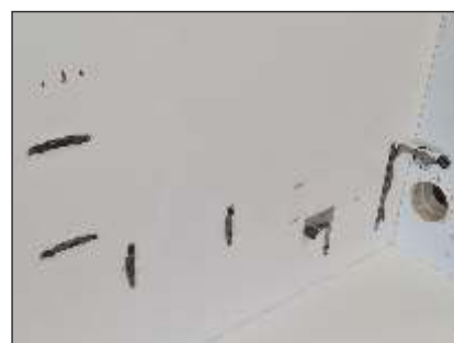
6 - Suportes de inox instalados
