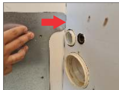
3 - Encostar o gabarito no shaft
