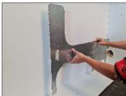
1 - Gabarito de furação de parede
