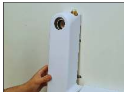
12 - Instalar carenagem Ø40
