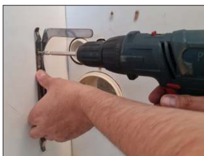
5 - Parafusar os suportes de inox na parede
