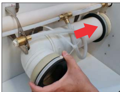
8 - Instalação do PVC Ø100
