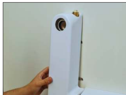
12 - Instalar carenagem Ø40
