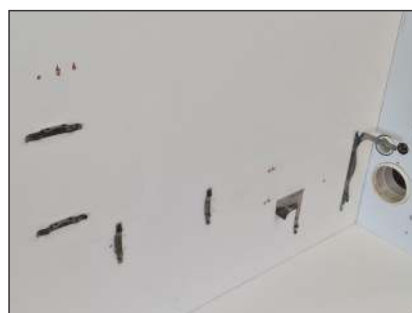
6 - Suportes de inox instalados
