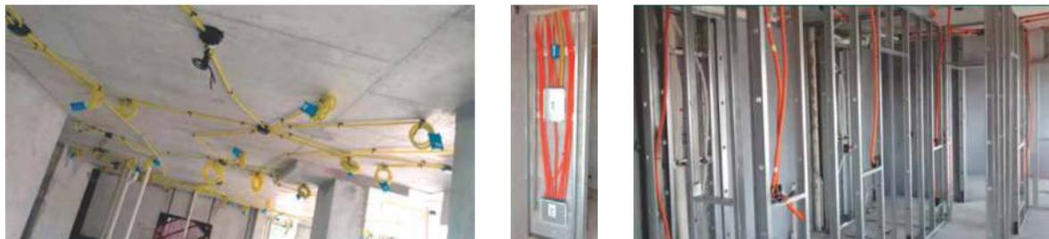
**INSTALAÇÕES EMBUTIDAS NA LAJE, EM PAREDES ESTRUTURAIS OU ESTRUTURA CONVENCIONAL E ALVENARIA DE VEDAÇÃO**
