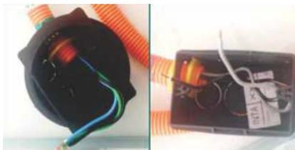
União com as caixas 4x2 4x4 com travas, evitando o desprendimento do eletroduto da caixa
