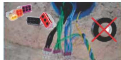
Conexão com pressão de contato constante, elimina fugas de corrente elétrica
