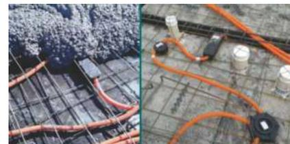
Caixas de laje, união direta do eletroduto, 100% estanque, evitando o entupimento pelo concreto;
