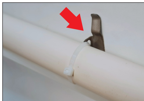
23 - Fixação entre o suporte e o kit hidráulico com a abraçadeira de nylon natural - 280 x 4,8mm (A fixação deve ser feita somente no tubo PVC Ø40)
