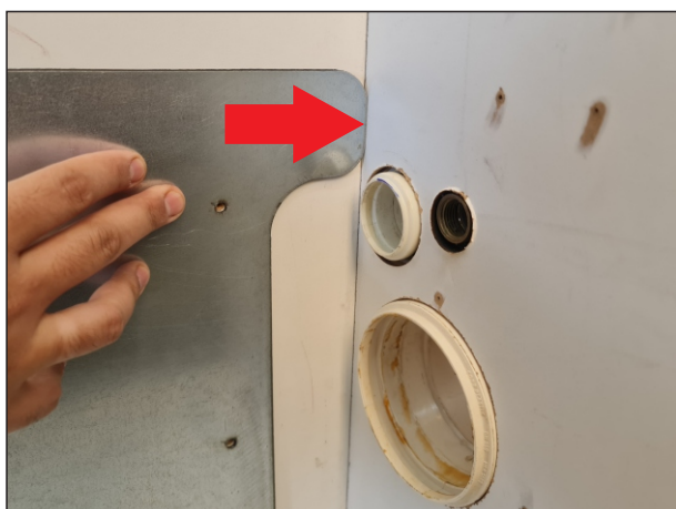
3 - Encostar o gabarito no shaft
