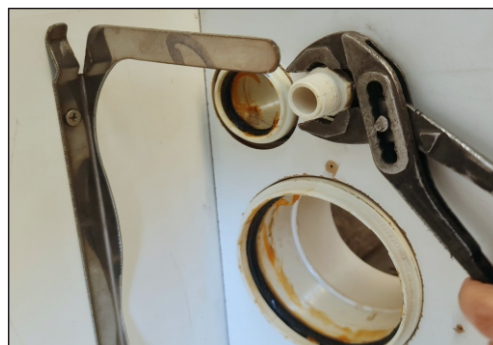
11 - Fixar niple 1/2" na rosca fêmea da parede
