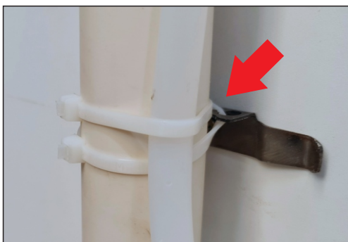
23 - Fixação entre o suporte e o kit hidráulico com a abraçadeira de nylon natural - 280 x 4,8mm (A fixação deve ser feita somente no tubo PVC Ø40)
