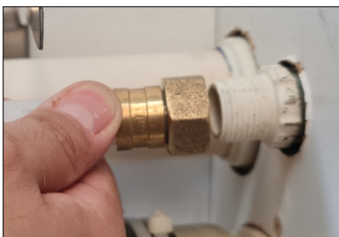
21 - Instalação do tubo PEX
