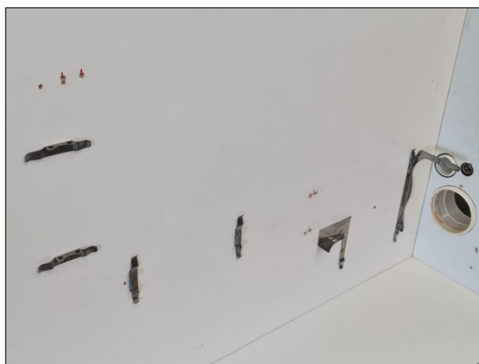
9 - Suportes de inox instalados
