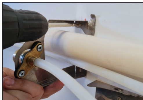
18 - Parafusar o suporte de água fria da caixa acoplada
