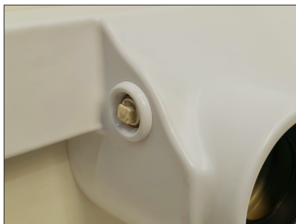
37 - Canopla de acabamento instalada
