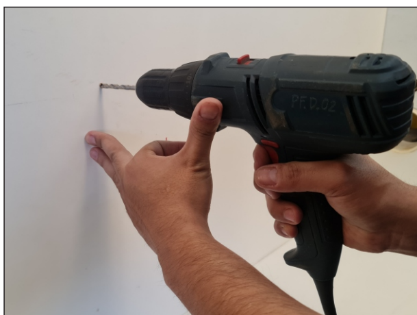
5 - Fazer a furação com broca widea Ø6mm nos pontos marcados
