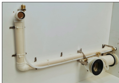
31 - Kit hidráulico completo instalado
