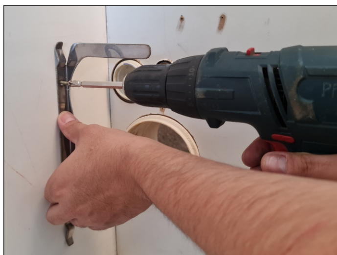
8 - Parafusar os suportes de inox na parede
