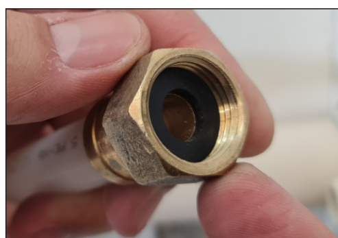
20 - Borracha de vedação corretamente posicionada na conexão
