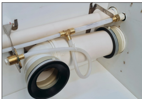
30 - PVC Ø100 já instalado
