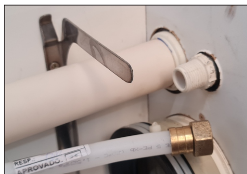
16 - PVC Ø40 instalado
