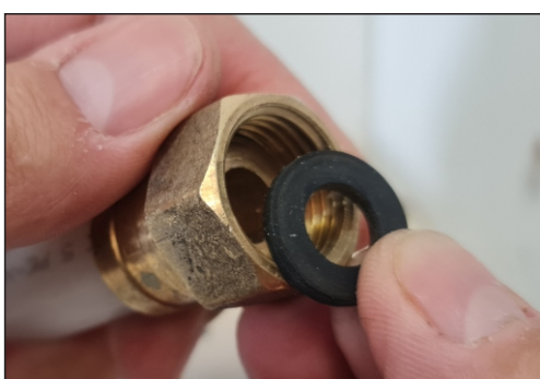
19 - Verificar se a borracha de vedação está inserida na conexão
