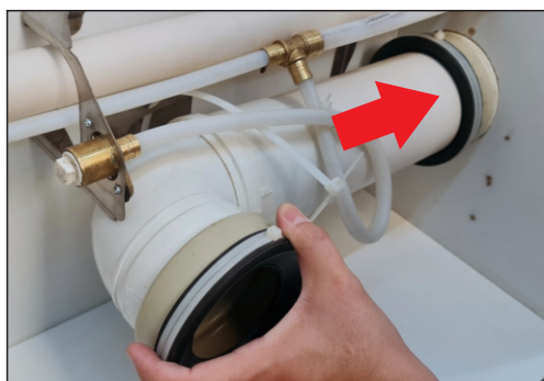
28 - Instalação do PVC Ø100
