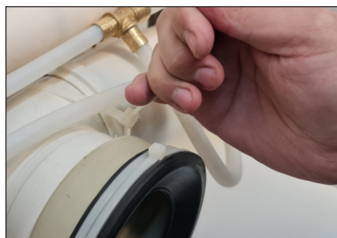
29 - Fixar o joelho Ø100 com a abraçadeira de nylon
