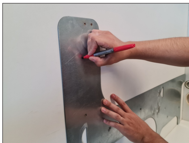
4 - Fazer a marcação dos pontos de furação
